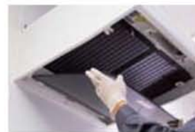
カバーを外して、内部のファンまで分解洗浄! 換気効率大幅アップ!
